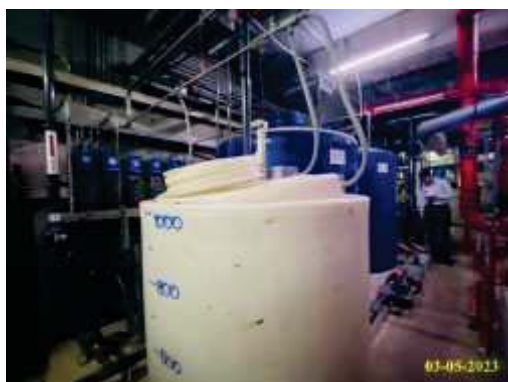
ภาพที่ 1.3.4-2 ระบบรีไซเคิลน้ำ
